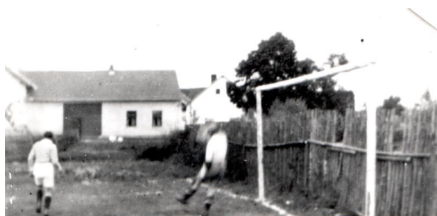
Obrázek 1 Hřiště prvního sportovního klubu v obci Cejle vybudované v roce 1933
