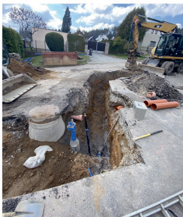
Budování vodovodních řadů
